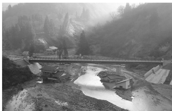
橋梁(木籠橋)完成状況
