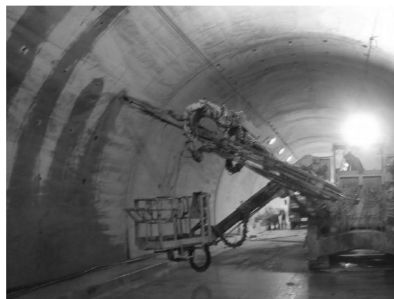
ロックボルト施工状況
