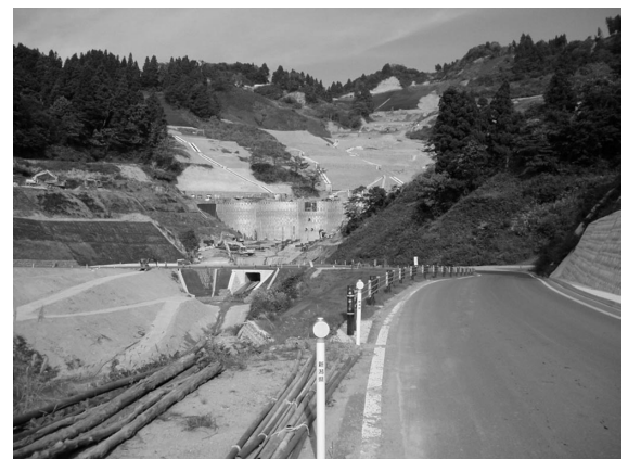
復旧完了②
