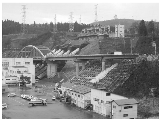
復旧状況写真
