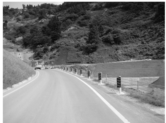
復旧完了①
