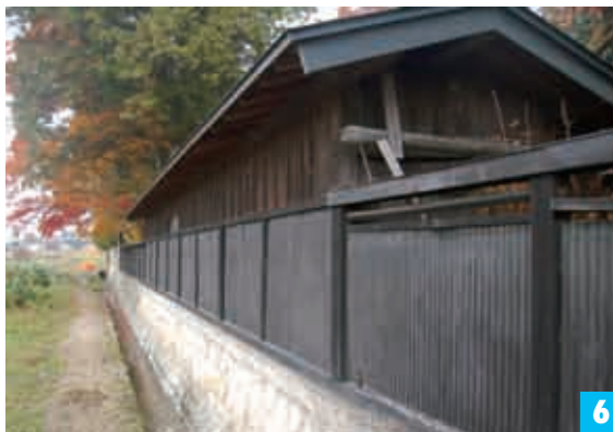
武井孝夫宅の西側 JR大系線に面しており、低い塀と倉庫が配置されている。
