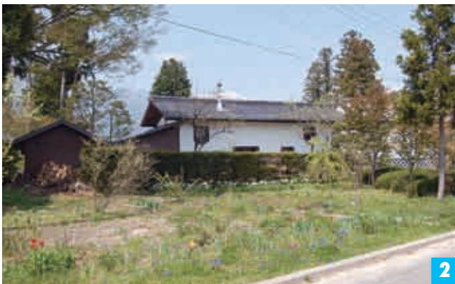
吉田宅の母屋 2棟並んだ土蔵の間を入ると築170年余りの切妻平入、亜鉛鋼板葺きの母屋がある(改築前は板葺き)
