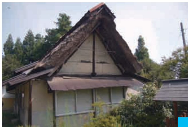
平林伊三郎宅のケミヤ（作業小屋）は珍しい稲藁葺の切妻屋根である（2 3）
