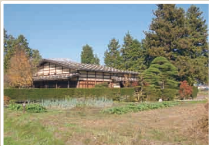
重要文化財・曾根原家住宅の外観
