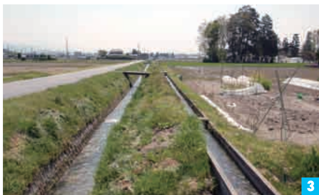
圃場整備された農地は縦横に水路が整備され、農道からは水路に架けられた橋を渡って田圃に入る
