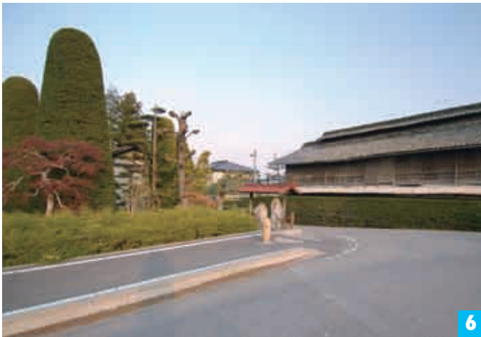
すでに解体された繭倉
