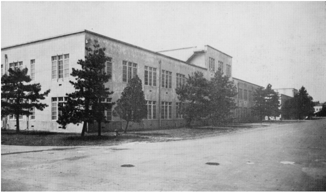
旧燃料廠第一・第二研究室
