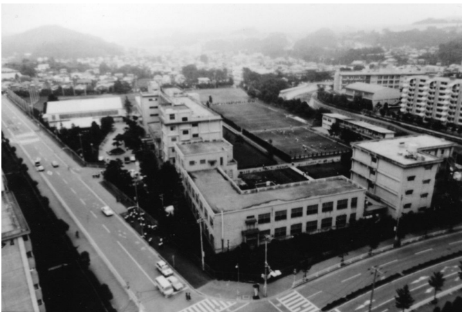
柏陽高校 A 棟建設後の全景
