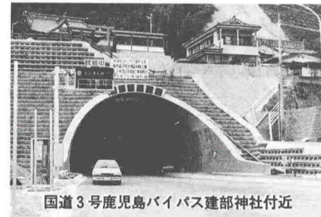
国道3号鹿児島バイパス建設部社付近
