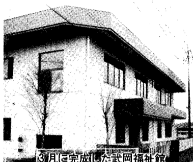
3月に完成した武岡福祉館
