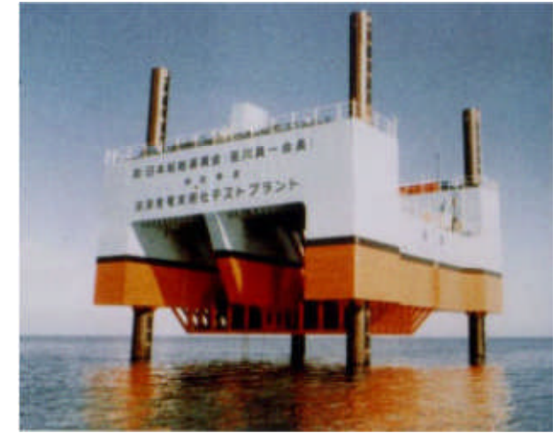
図16 マイティホエール 振動水柱型波力発電浮体(出典:海洋研究開発機構) 図17 海陽 (出典:日本造船振興財団)
