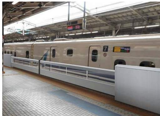
大開口可動柵設置イメージ
