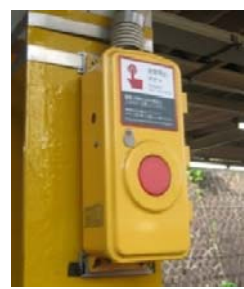
②非常通報灯（出発側）の設置、および非常停止押しボタンの増設 うち3駅を整備済み、続いて40駅を整備予定（～H25年度）
