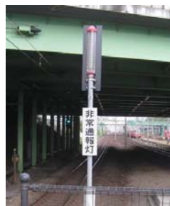
②非常通報灯（出発側）の設置、および非常停止押しボタンの増設 うち3駅を整備済み、続いて40駅を整備予定（～H25年度）
