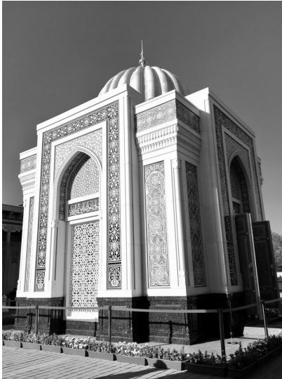
写真2 完成したカリモフ廟 (写真1とほぼ同じ位置から撮ったもの)
