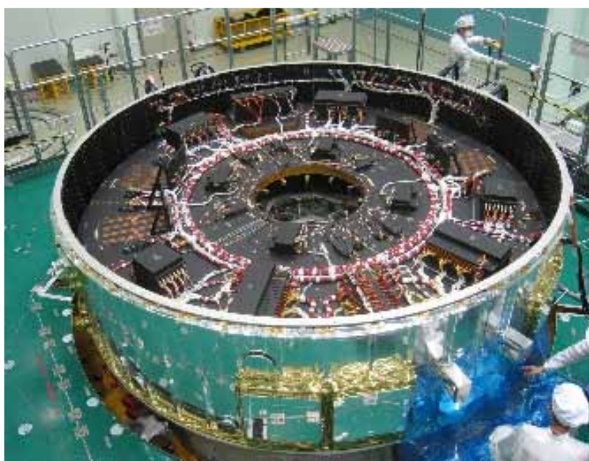
図2.4.4-2 電気モジュールの内部 (HTV2)
