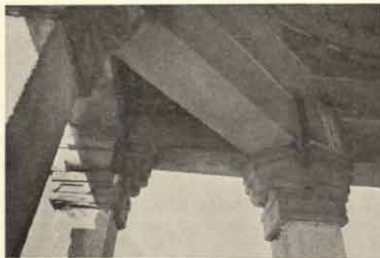
挿図 54 内部西北隅 見上げ
