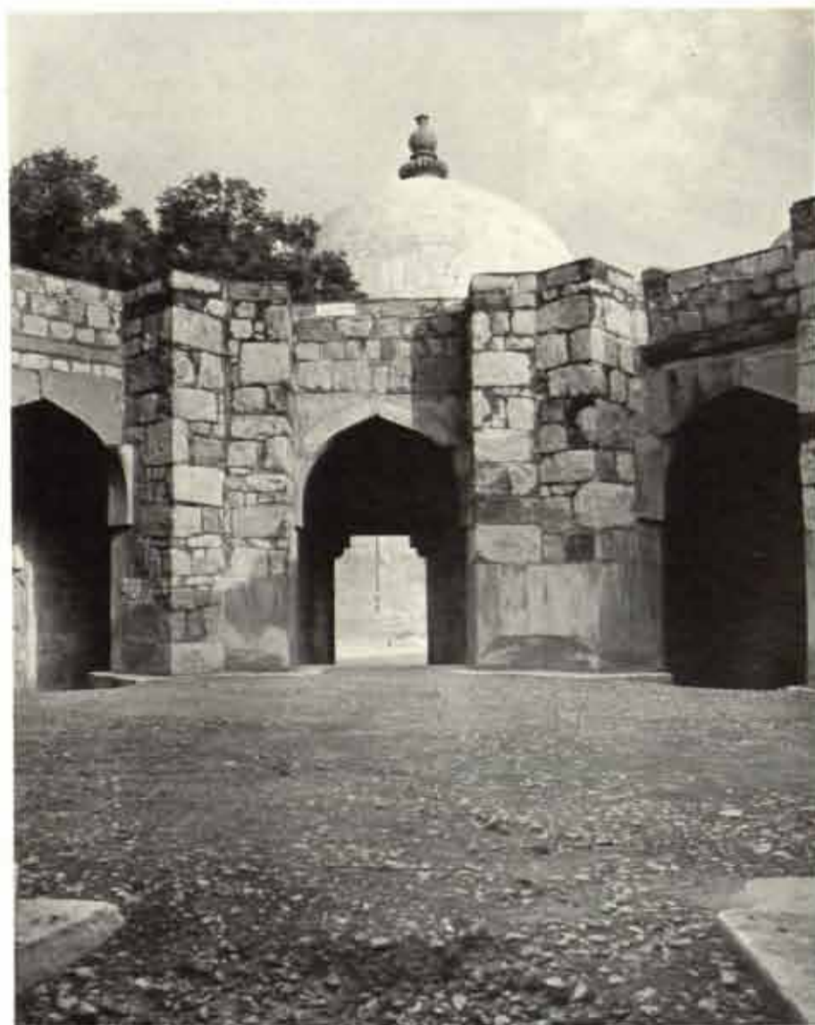
c. 同上 西バステイオン内部の建造物 西より
