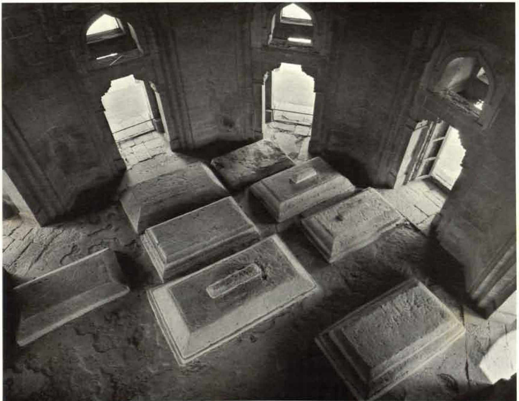
c. 墓室内部の墓 西北より
