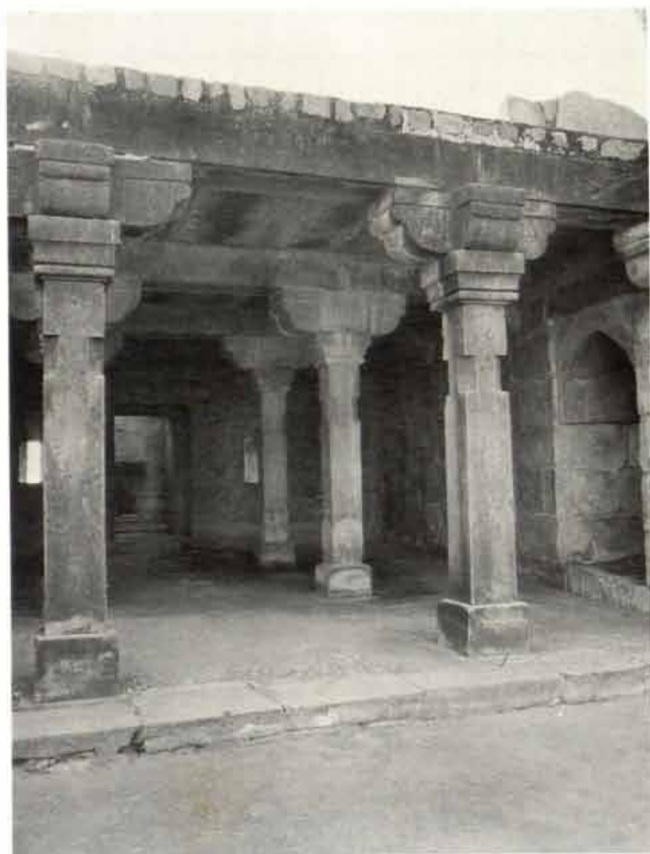
b 同上 南張り出し部分 北面
