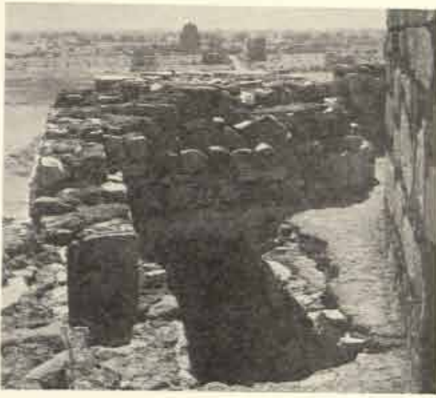
挿図 24 東北チャハトリ基台と屋上出口 西より
