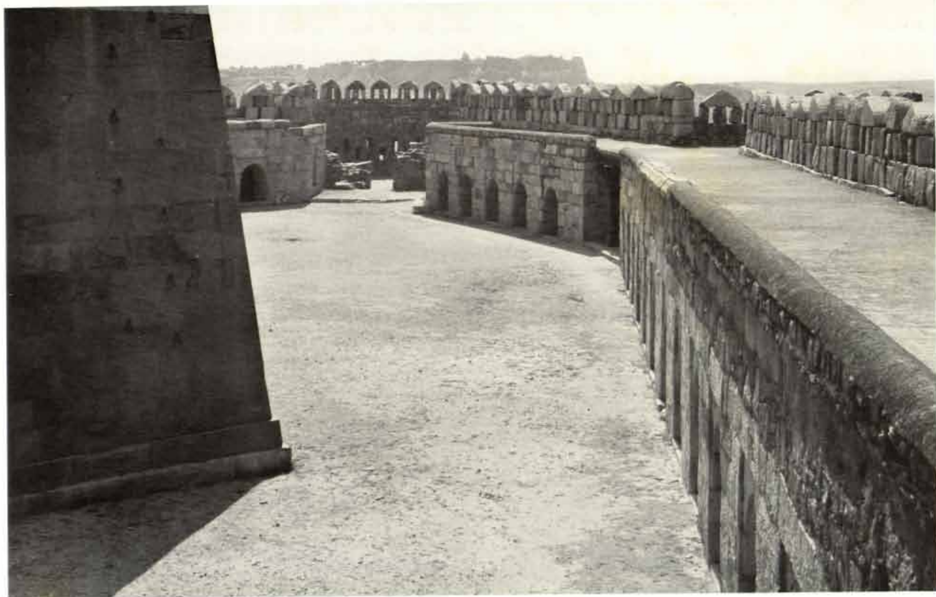
a 小城砦 南側廻廊 西北より
