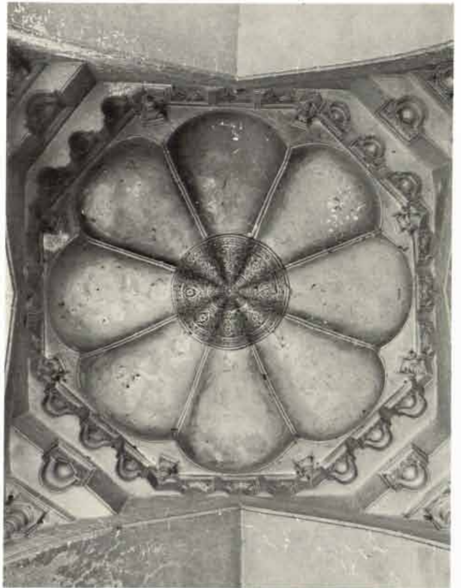
b 西南廻廊天井 中央部分
