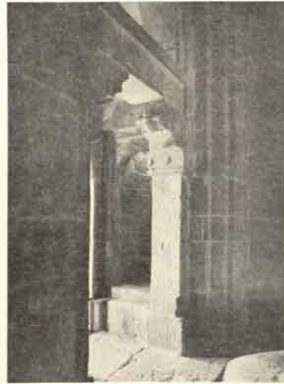
挿図 44 階段入口 東より
