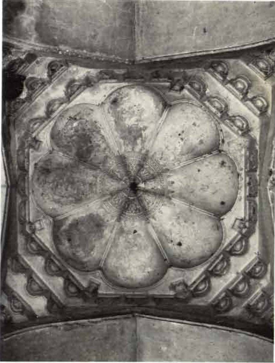
a 南廻廊天井 中央部分
