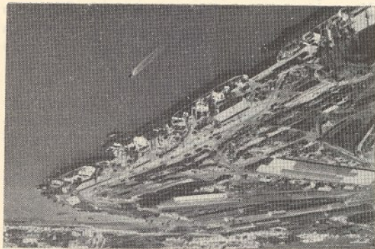
Vista aérea do porto da Beira
