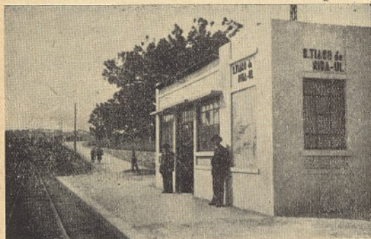
S. TIAGO DE RIBA-UL — Edifício da nova estação
