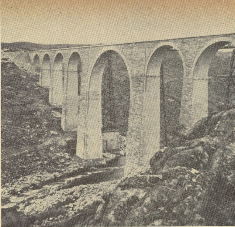
Ponte sobre o Côa
