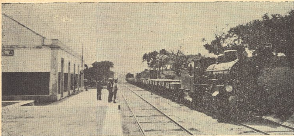
BALASTRAGEM — PINHAL NOVO-FUNCHEIRA — Um comboio especial de balastro
