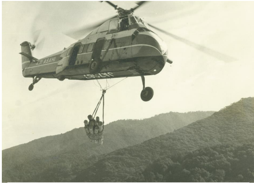
御母衣ダムの建設において物資輸送で活躍する S-58
