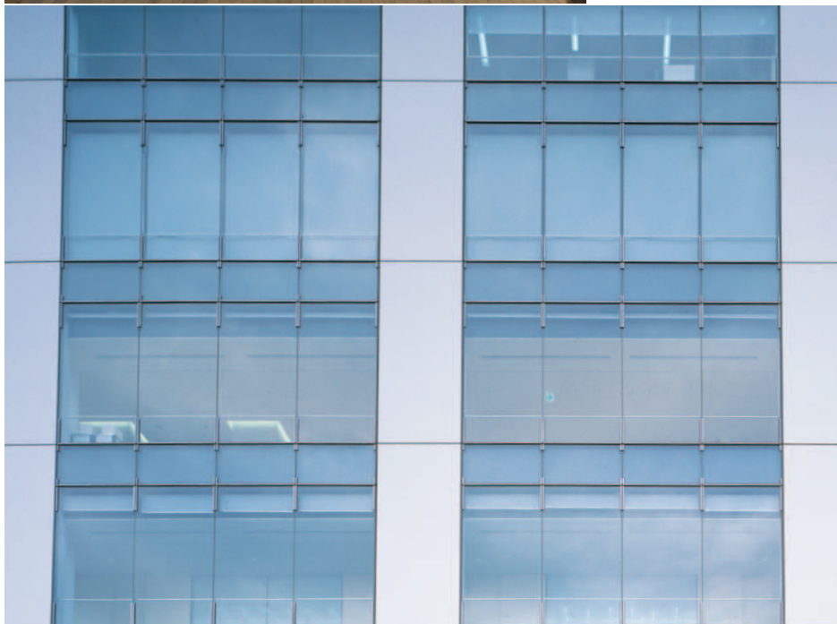
室内からは開放的な眺望が確保されている。足元部の支持部材は、手すりと一体化されたデザイン（写真左）。ミニマムに設計された支持部材が、低層部のガラスカーテンウォールのすっきりとしたデザインを実現した
