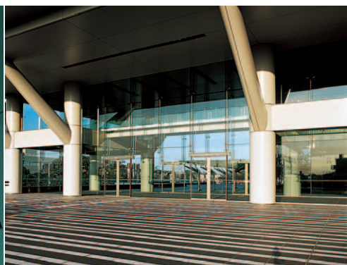
支持構造体としてのリブガラスをダブルで用いている(写真左)。DPG構法とリブガラス(ハーフ)の組み合わせが、透明感の高いエントランスを創り出した
