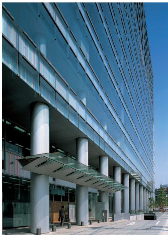
透視性の高いガラス面を実現した(写真左)。一般のオフィス階でも、リブガラスによって足元まで開放感のある執務空間を創り出した
