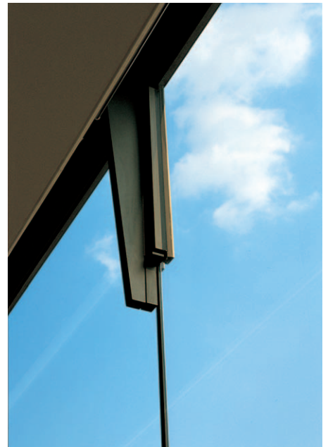
縦型のスチール製バー材と内観天井部の取り合い
