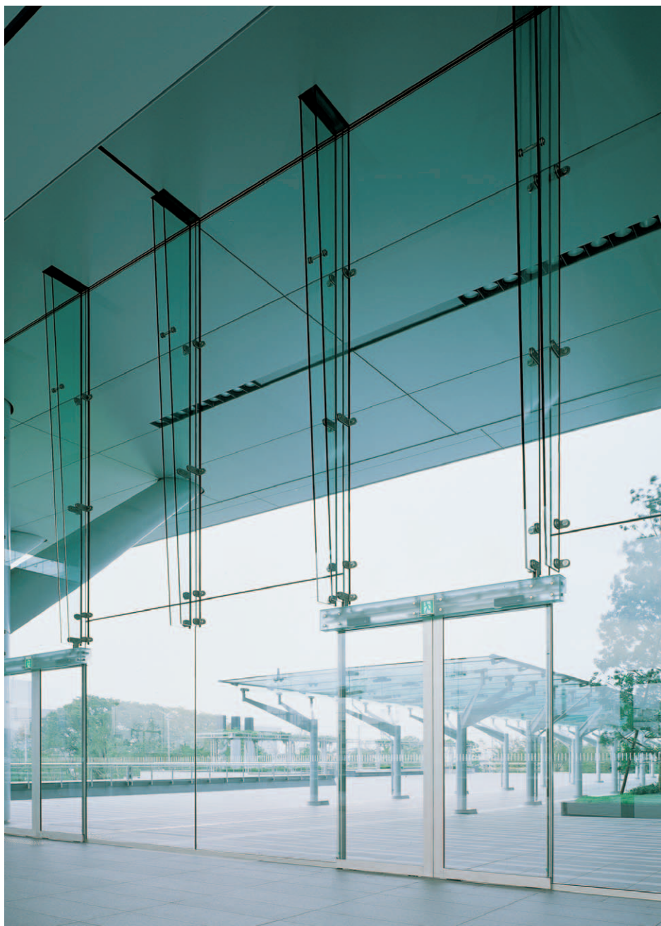
支持構造体としてのリブガラスをダブルで用いている(写真左)。DPG構法とリブガラス(ハーフ)の組み合わせが、透明感の高いエントランスを創り出した
