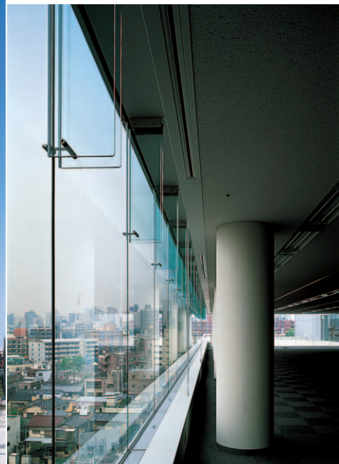
透視性の高いガラス面を実現した(写真左)。一般のオフィス階でも、リブガラスによって足元まで開放感のある執務空間を創り出した
