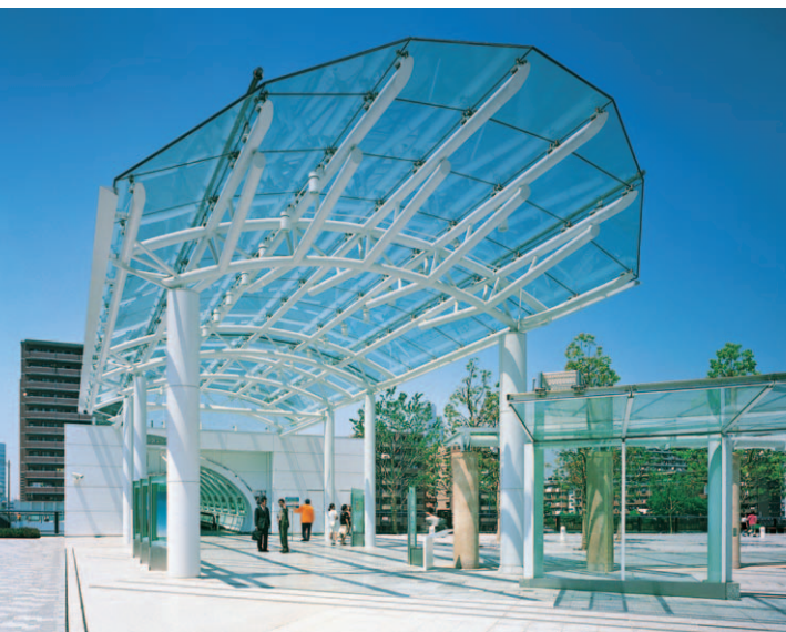
動く歩道のキャノピーは、DPG構法によるガラスを、下からスチールトラスで支えている
