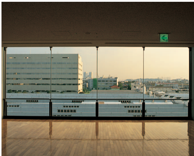
室内からは開放的な眺望が確保されている。足元部の支持部材は、手すりと一体化されたデザイン（写真左）。ミニマムに設計された支持部材が、低層部のガラスカーテンウォールのすっきりとしたデザインを実現した
