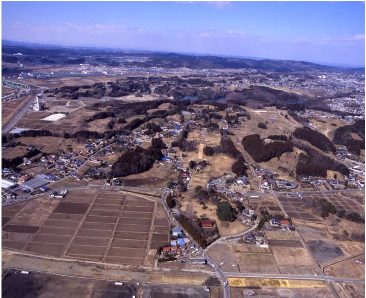
写真3 南上空より多賀城跡全体を望む。中心部が政庁跡。
