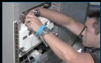
空調/熱制御ラック背面からポンプ交換作業を行う
