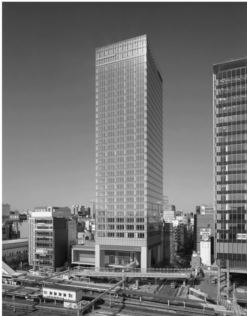
写真 - 1 建物外観
