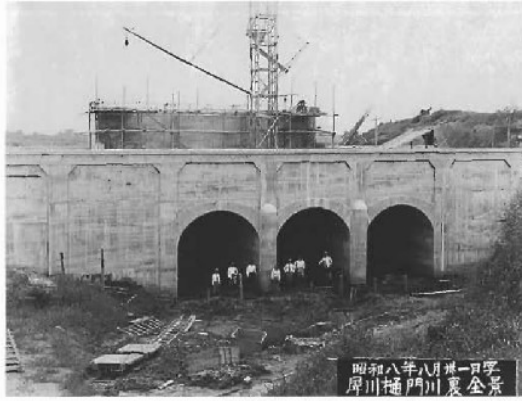
昭和八年八月一日宇 屏川樋門川裏全景 屏川樋門川裏全景 (昭和八年八月三十一日撮影)
