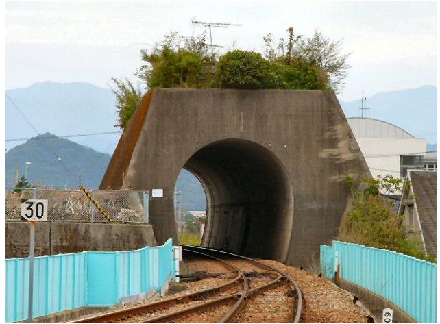
写真1 海部駅から望む町内トンネル（現在）
