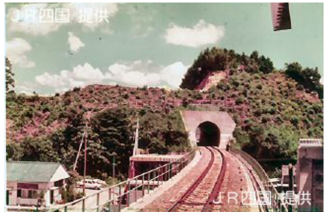
写真2 地山が残っていた当時の町内トンネル
