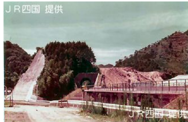
写真3 地山が残っていた当時の町内トンネル
