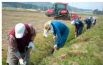
水路の泥上げ
