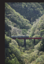
6.荒沢川橋梁 作並～奥新川間
