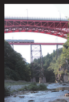
4.第二広瀬川橋梁 手前は国道48号線の能ヶ根橋
