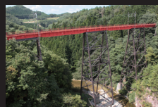
3.第二広瀬川橋梁(通称・能ヶ根鉄橋) 陸前白沢～能ヶ根間
