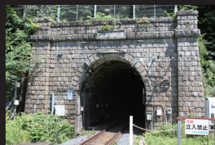
7.仙山隧道 面白山側坑口 「坑門は山間僻地にあるが、国内3位の長大隧道に相応しい剛健の気風な花崗岩で張る事」との工事誌記載がある。
