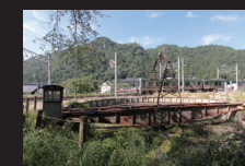
12.山寺駅の転車台
