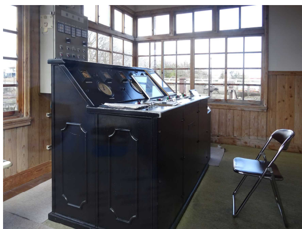
〔写真2〕 中島閘門の閘門操作所 (2019/02/10)
