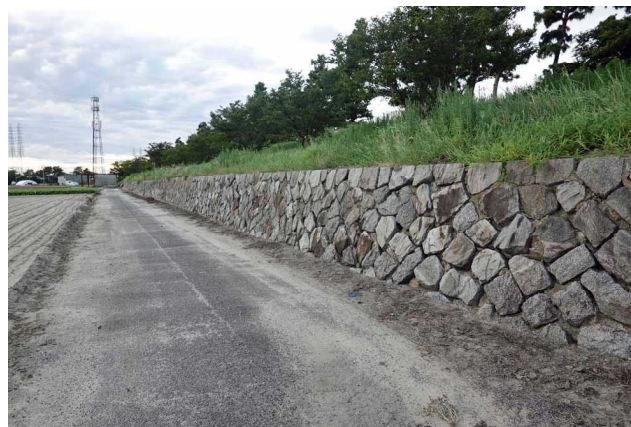
写真1 前浜新田人造石護岸の現状(堤防左側は碧南干拓、堤防右側が前浜新田)(2019.8.6筆者撮影)
