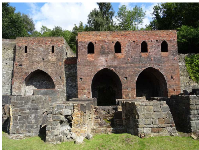
【写真3】 ブリスツ・ヒル高炉の遺構 (2019/08/20)
