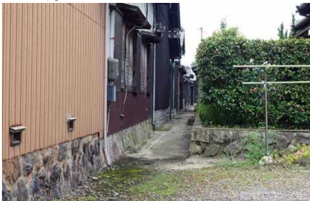
写真3 人造石の腰壁や基礎を持つ民家が建ち並ぶ集落（碧南市前浜町、2019.7.12筆者撮影）
