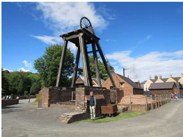
[写真6] ブリスツ・ヒル鉱山の縦坑櫓 (2015/08/27)
