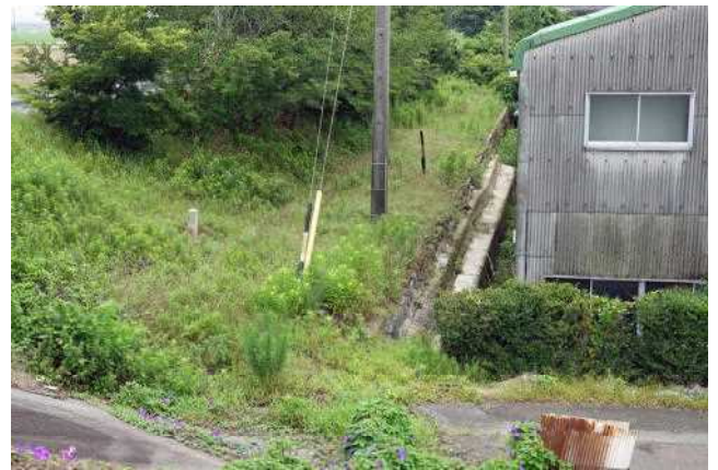
写真2 前浜新田の三重壁の護岸と、二段になった堤防法面形状も良く残している(2019.7.12筆者撮影)
