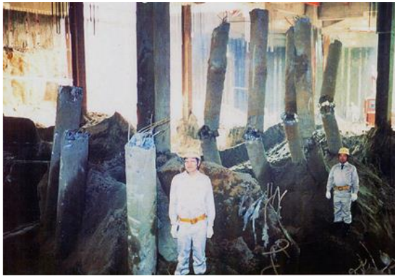
図3 1964年新潟地震によるNビルの杭基礎の被害（写真：河村壮一氏提供、図面：西沢ほか2名 新潟地震時に破損した既製RCぐいの調査と耐震解析、日本建築学会大会学術講演梗概集、1982年10月、より引用）
