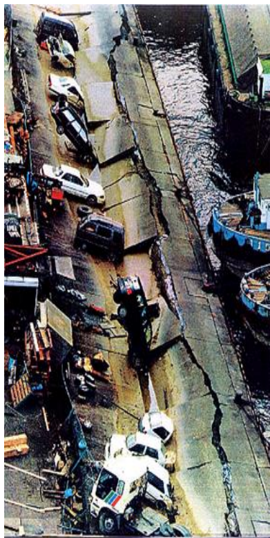
図6 1995年兵庫県南部地震による護岸付近での被害
