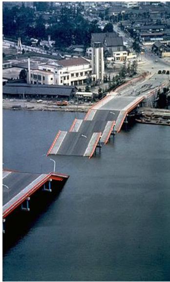
図5 1964年新潟地震で落橋した昭和大橋とP4橋脚の基礎杭の被害（土木学会新潟震災調査委員会編：昭和39年新潟地震震害調査報告、土木学会、1966年6月、より引用）
