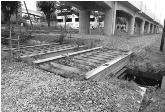
図5 東田中踏切跡から仙台方を見る
