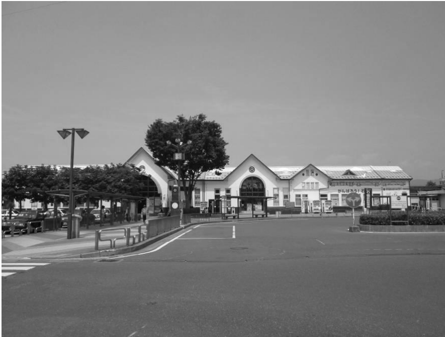
図37 石巻駅駅舎全景
