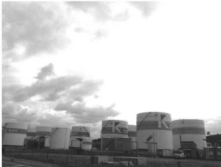
図22 貞山通地区海沿いのタンク
