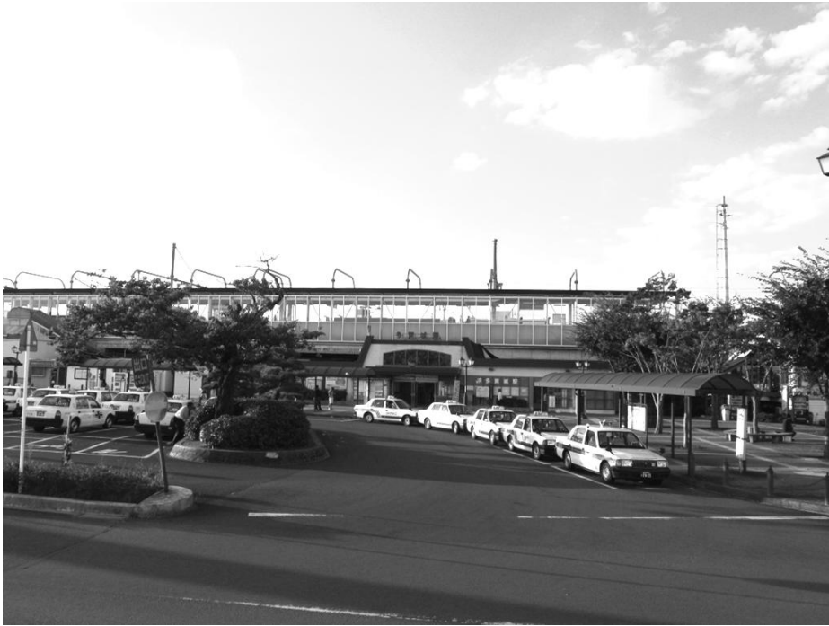
図2 多賀城駅舎全景
