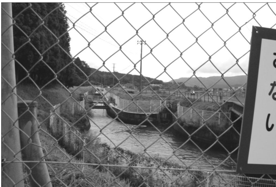
図3 開渠として流れていく導水路(A地点)
