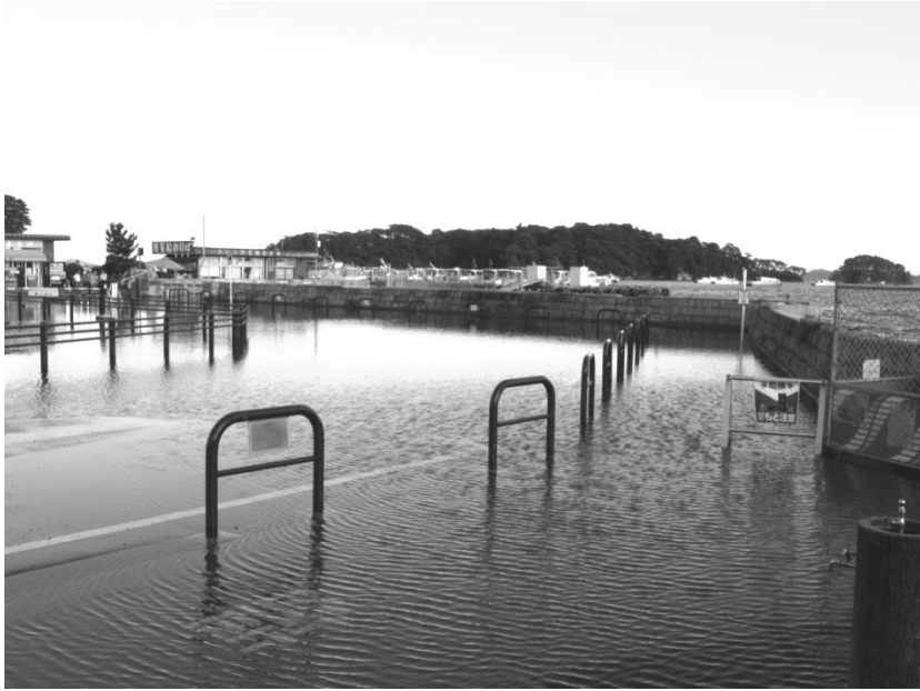
図32 ⑦地点での冠水の状況
