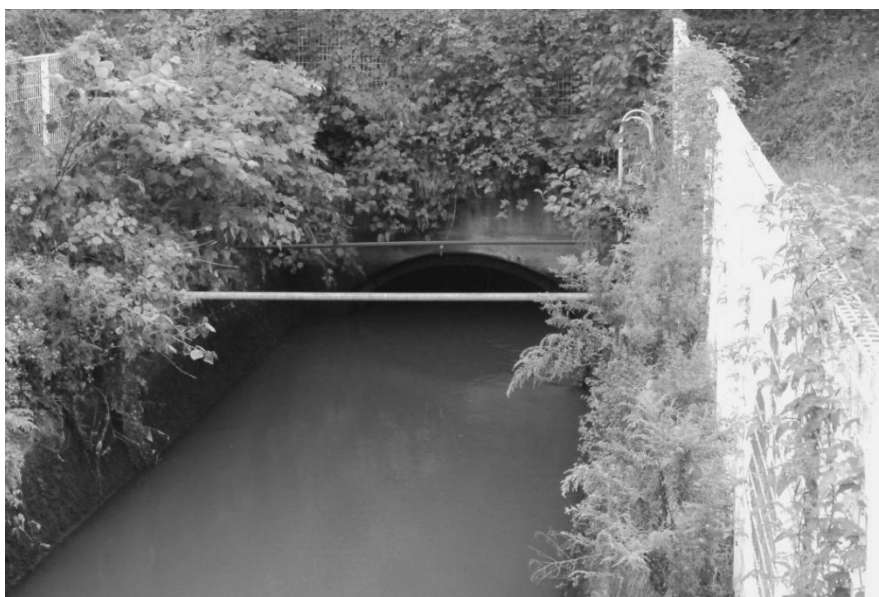
図4 取水堰から最初の水路トンネル(B地点)
