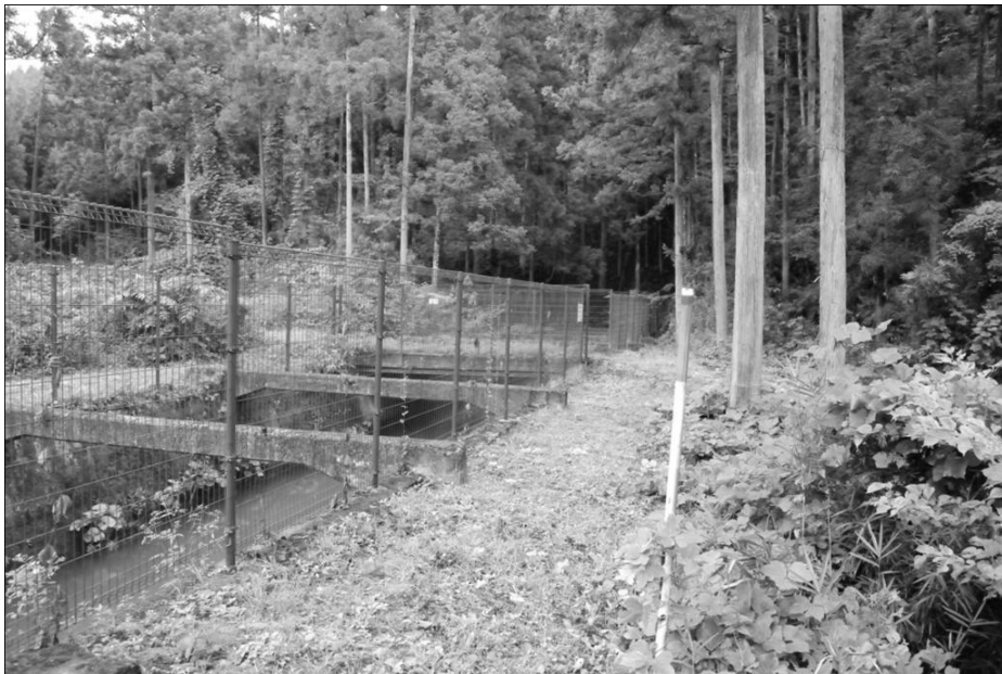
図9 谷間に現れた導水路 (D地点)
