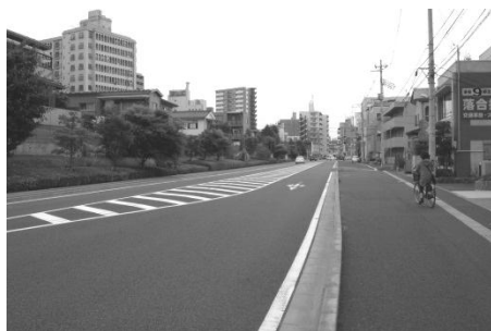
図16 道路に吸収された区間
