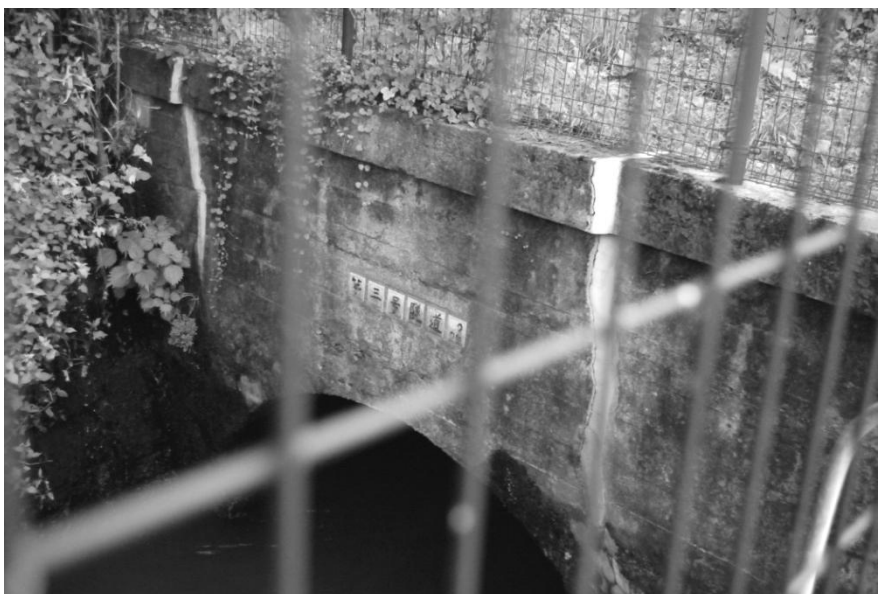
図7 「第三号隧道の2」の文字が残るトンネル(C地点付近)
