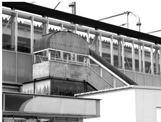
図5 地上駅当時の跨線橋
