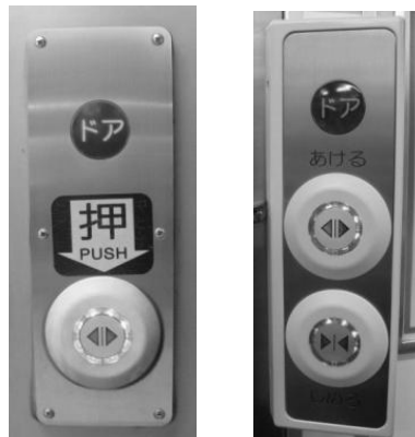
図3 新設された半自動ドアスイッチ (左)車外操作用 (右)車内操作用
