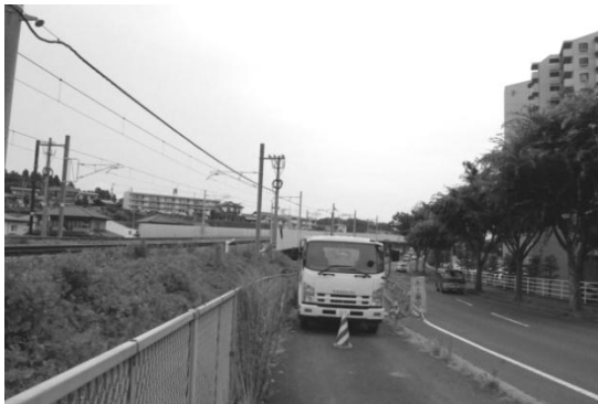
図2 仙台方高架終端部
