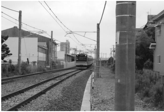
図8 石巻方高架終端部
