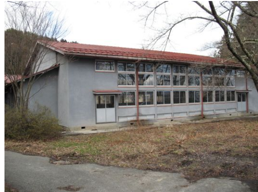
広津学校の体育館
