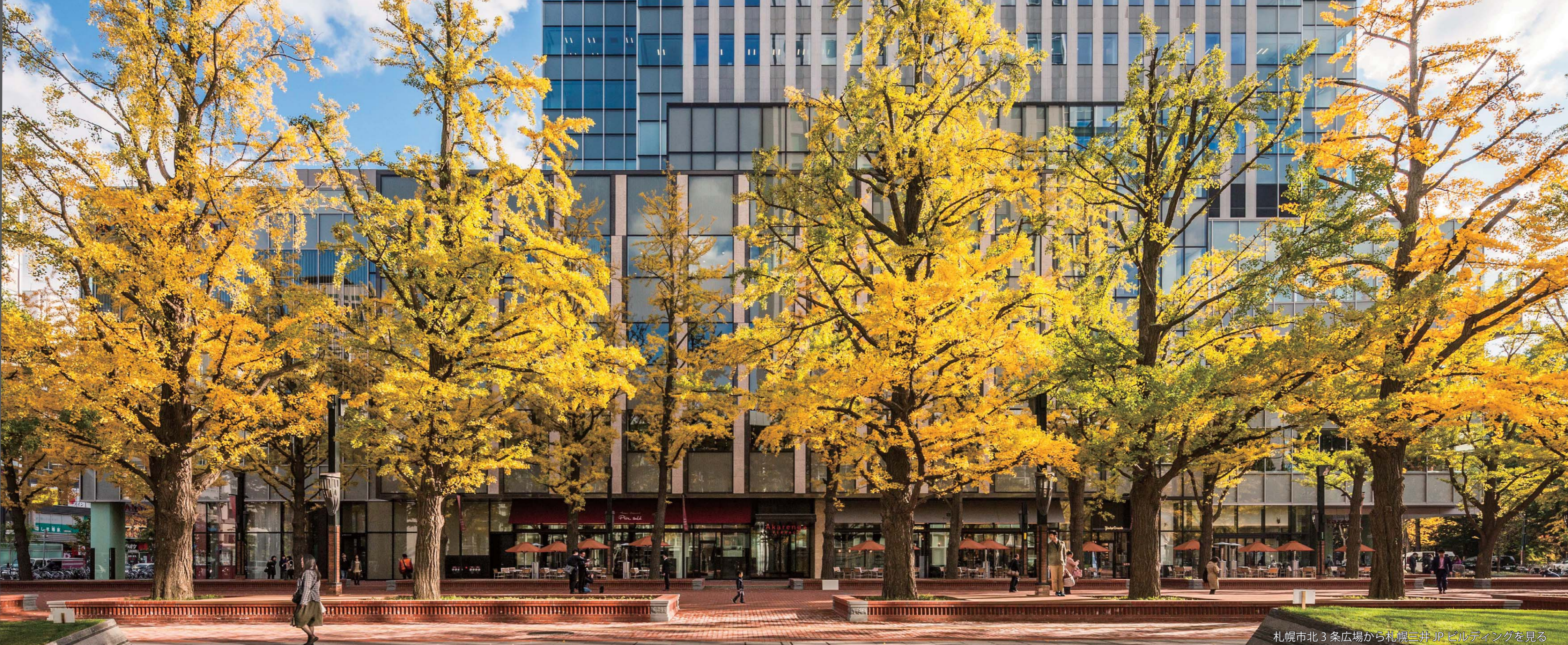
札幌市北3条広場から札幌三井JPビルディングを見る
