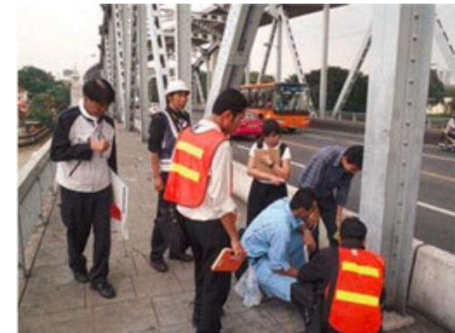
相手国技術者へ橋梁点検手法のOJT実施 (バンコク)
