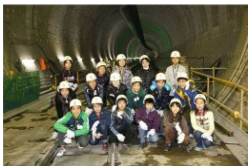
「つくる」 中央環状品川線シールドトンネル
