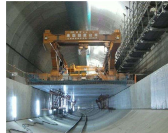
写真① 本線シールド内 (シールド掘進工、床版工を実施中)
