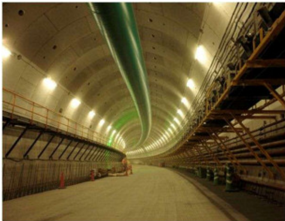
写真① 本線シールド内 (床版工、内装工等を実施中)
