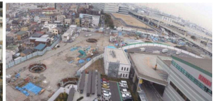
写真④ 生姜JCT (高架橋のケーソン基礎工を実施中)
