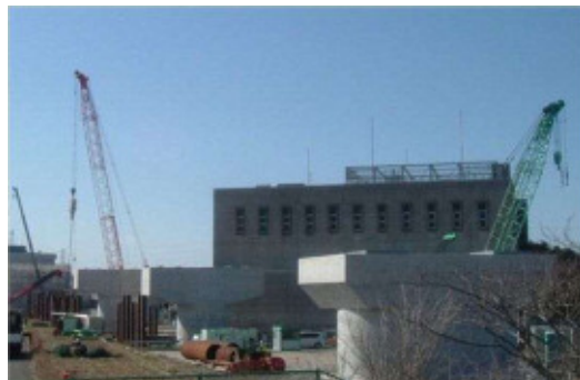
写真② 港北JCT～新横浜出入口 (高架橋の橋脚工を実施中)
