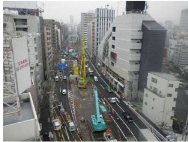
写真② 五反田出入口部付近 (土留工、掘削工等を実施中)
