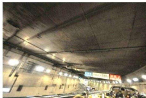
中央環状線大橋JCT内を走行
