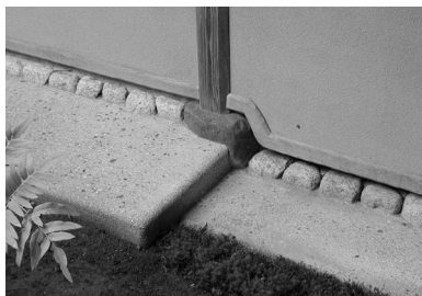
図7 S邸 段差の解消
