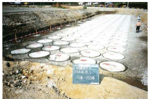
地盤改良工〔スラリー攪拌工(イメージ)〕
