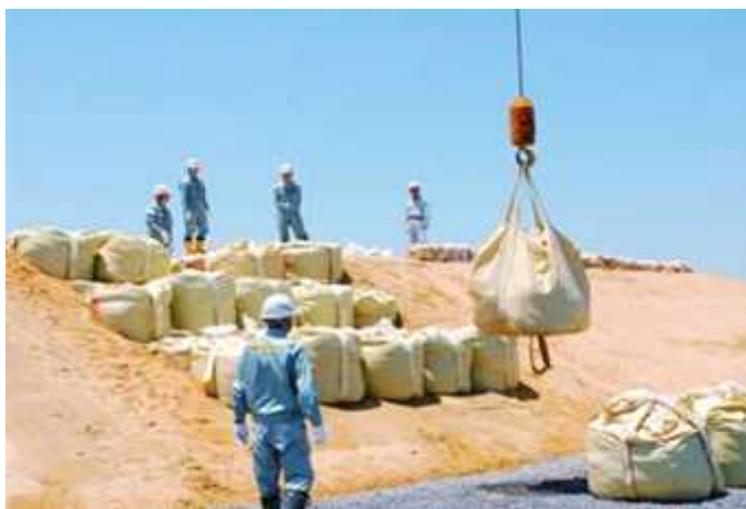
クレーン車による大型土のう設置状況
