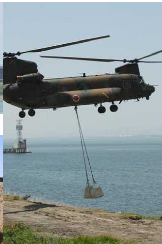
大型ヘリにより堤防復旧
