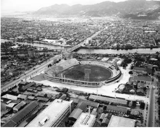
写真 10 第二期工事完成後の旧市民球場
