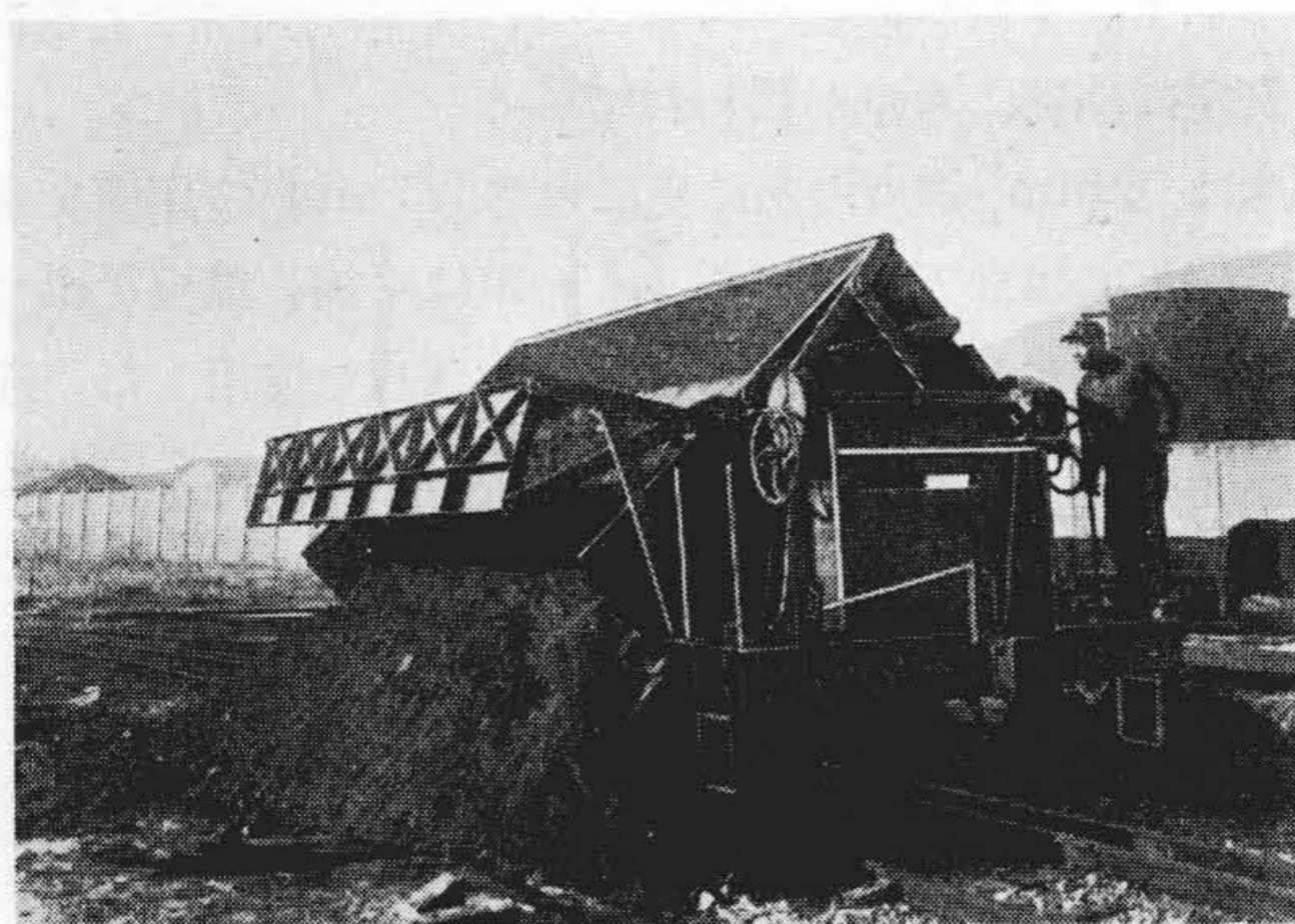
第 41 図 土砂排出中の 15t 積ダンプカー Fig. 41. 15t Dump Car, Dumped for Unloading
