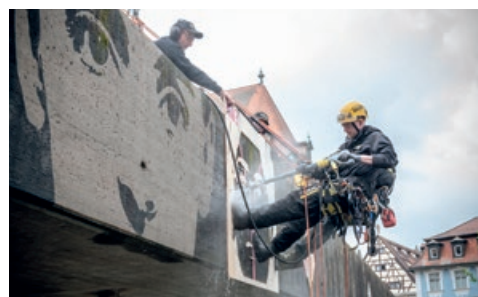
業務用冷水高圧洗浄機「HD 9/23 G」を使った洗浄作業
