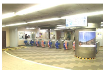
駅舎の改修（本厚木駅）
