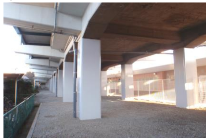
耐震補強工事（大和駅）※イメージ
