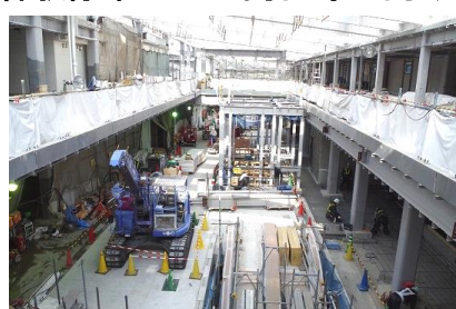
複々線化工事（下北沢駅） 地上コンコース
