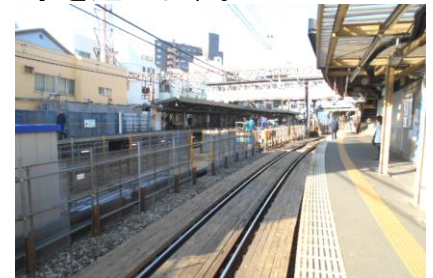
各停10両化工事（代々木八幡駅）
