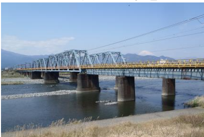
耐震補強工事（酒匂川橋梁）
