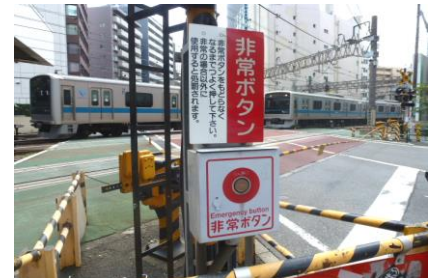
非常ボタンの増設（踏切）
