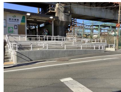
スロープ (浜川崎駅)
