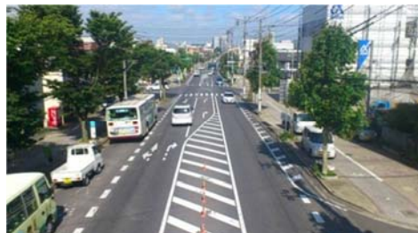
県道外川港線と沿線市街地
