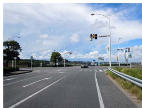
国道 356 号バイパス （利根かもめ大橋付近）
