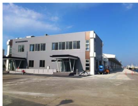
新たな銚子漁港第一卸売市場
