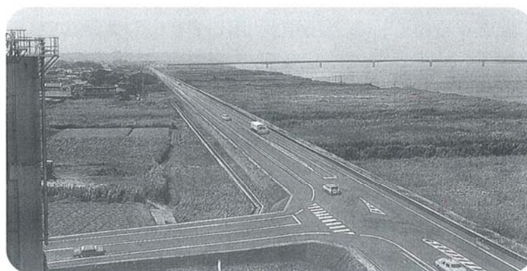
国道 356 号バイパスと利根かもめ大橋（イメージ）
