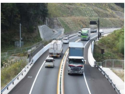
② 暫定2車線での部分開通区間
