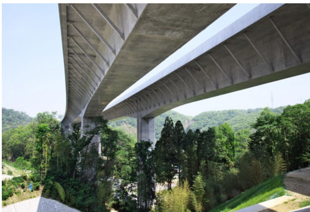
写真-2 ストラット付 PC 箱桁橋（郡界川橋）
