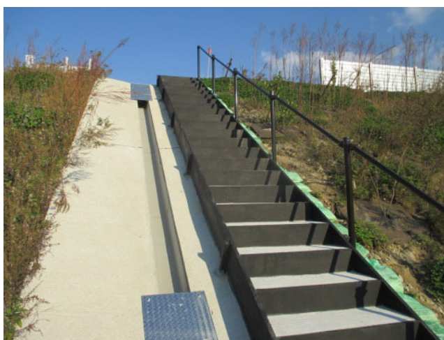
写真－5 のり面点検階段と手摺り
