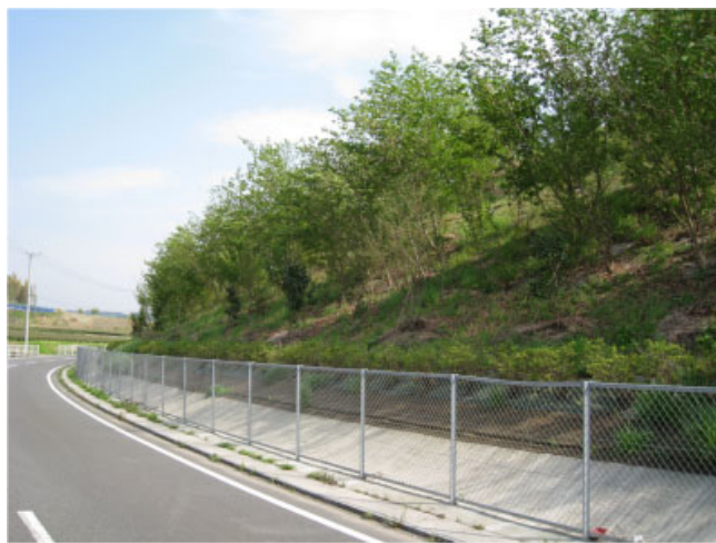
写真－10 のり面への植栽状況
