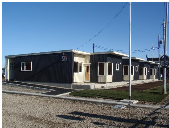
公営住宅（改築後の若葉団地）
