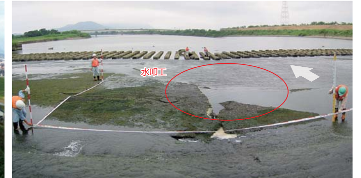
平成16年7月 第一床固被災
