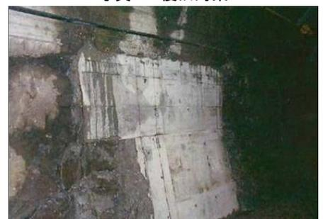
化状況、浮石状況等を目視及び打音にて調査し、その結果対策工が必要なトンネルは12トンネル、延長約2.2kmであった。
