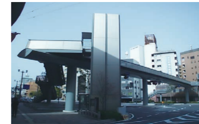
6 鷹野橋交差点横断歩道橋
