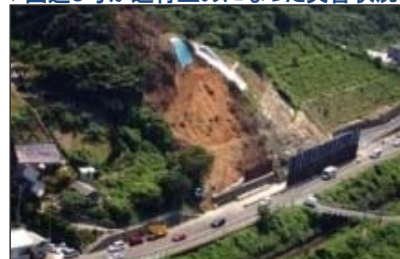
▼国道9号が通行止めになった災害状況
