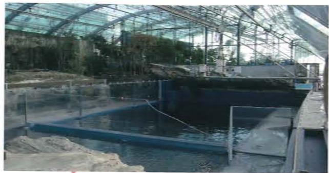
東日本大震災では、水族館の建物自体には大きな損傷はなかったものの、水槽のバックヤードに浸水し、展示生物の9割を失った。写真は、地震によって生じた水槽内の波の圧力で破壊された大水槽の亚克力板
