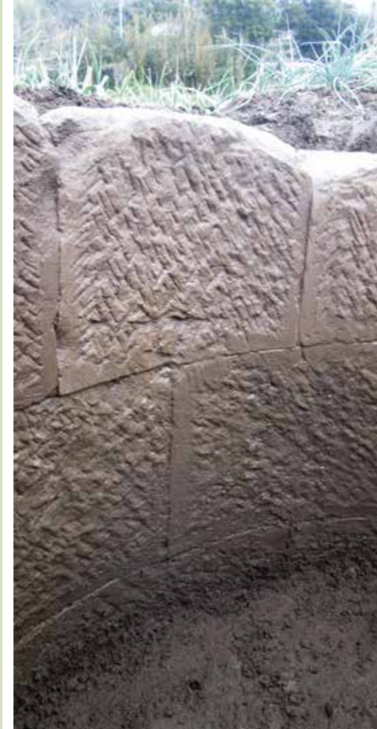
丁寧に調整した石を組んで隙間のない井戸枠をつくり出している
