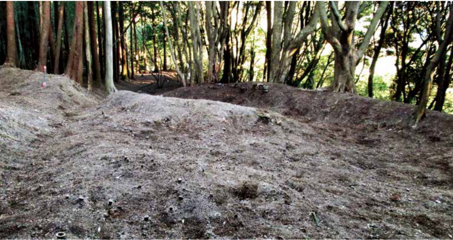
放棄竹林の竹を伐採して下草を刈り落葉を掃くと土手が切れていることが判明 東西に伸びる土手の先は頂部に礫が配され斜面が窪んだ状態となっていた
