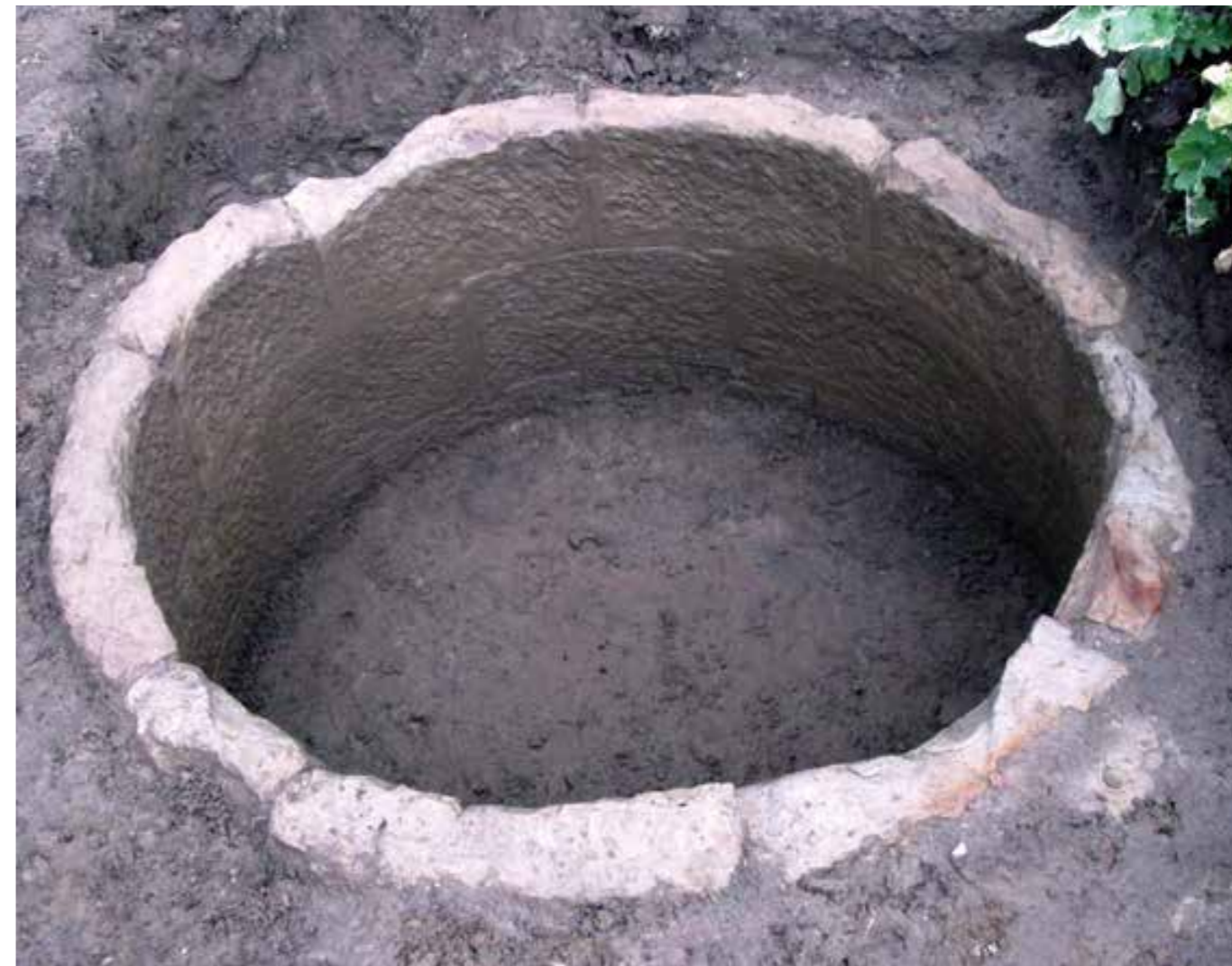
厚さ10cm、高さ約27cm、幅40cm前後の湾曲したシルト岩製石板で円形の井戸枠を構築 石を横に半分ずらして積み重ねている
