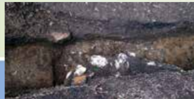
石積みと対面のクランク状土手基部の配石
