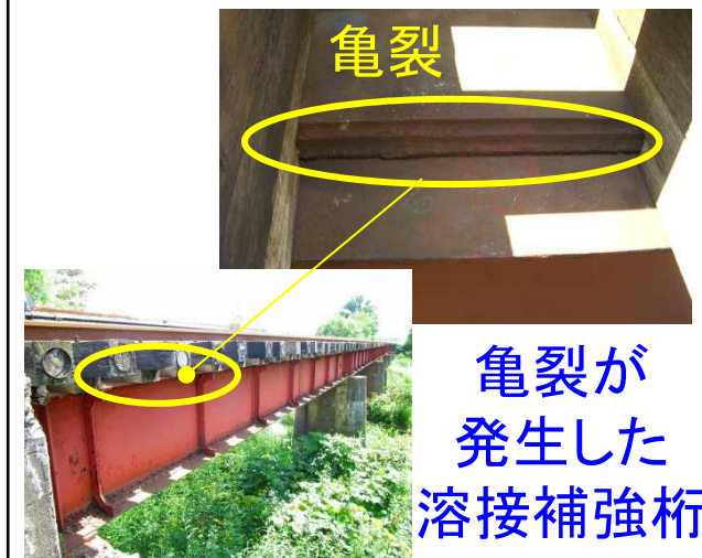
(例: 札沼線 知来乙・石狩月形間 須部都川橋りょう)
