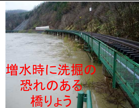
(例: 宗谷線 糠南・雄信内間 問平陸橋)
