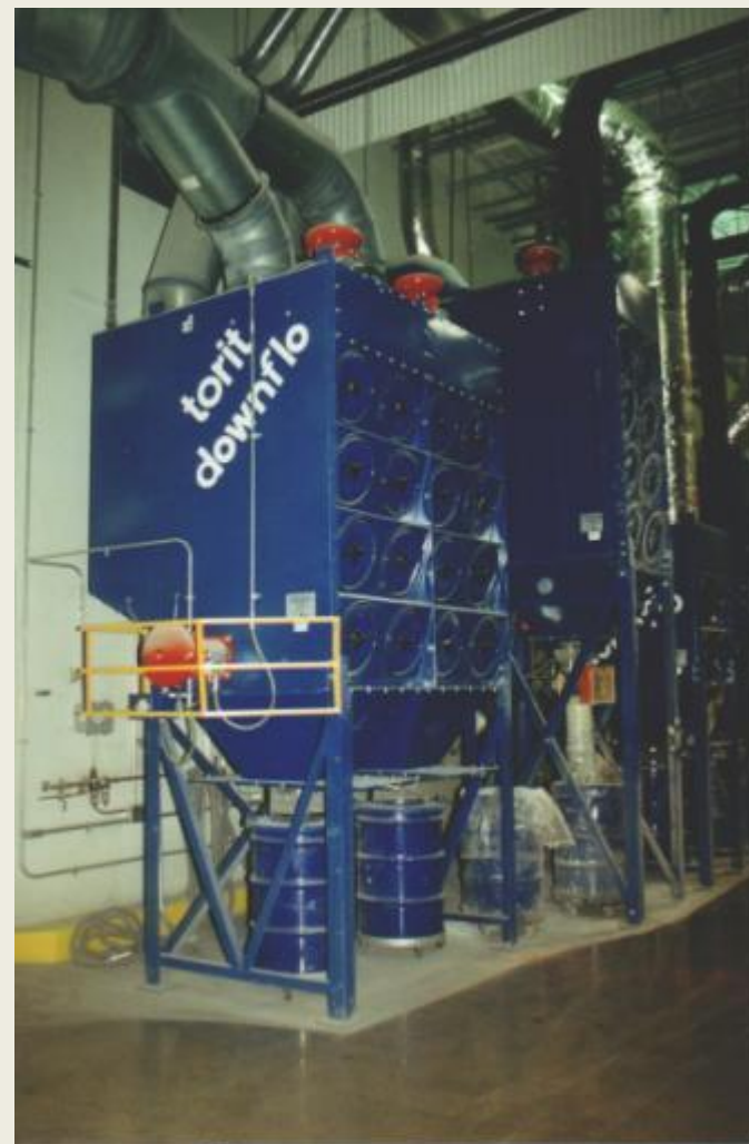
排出口の資材フィルター
