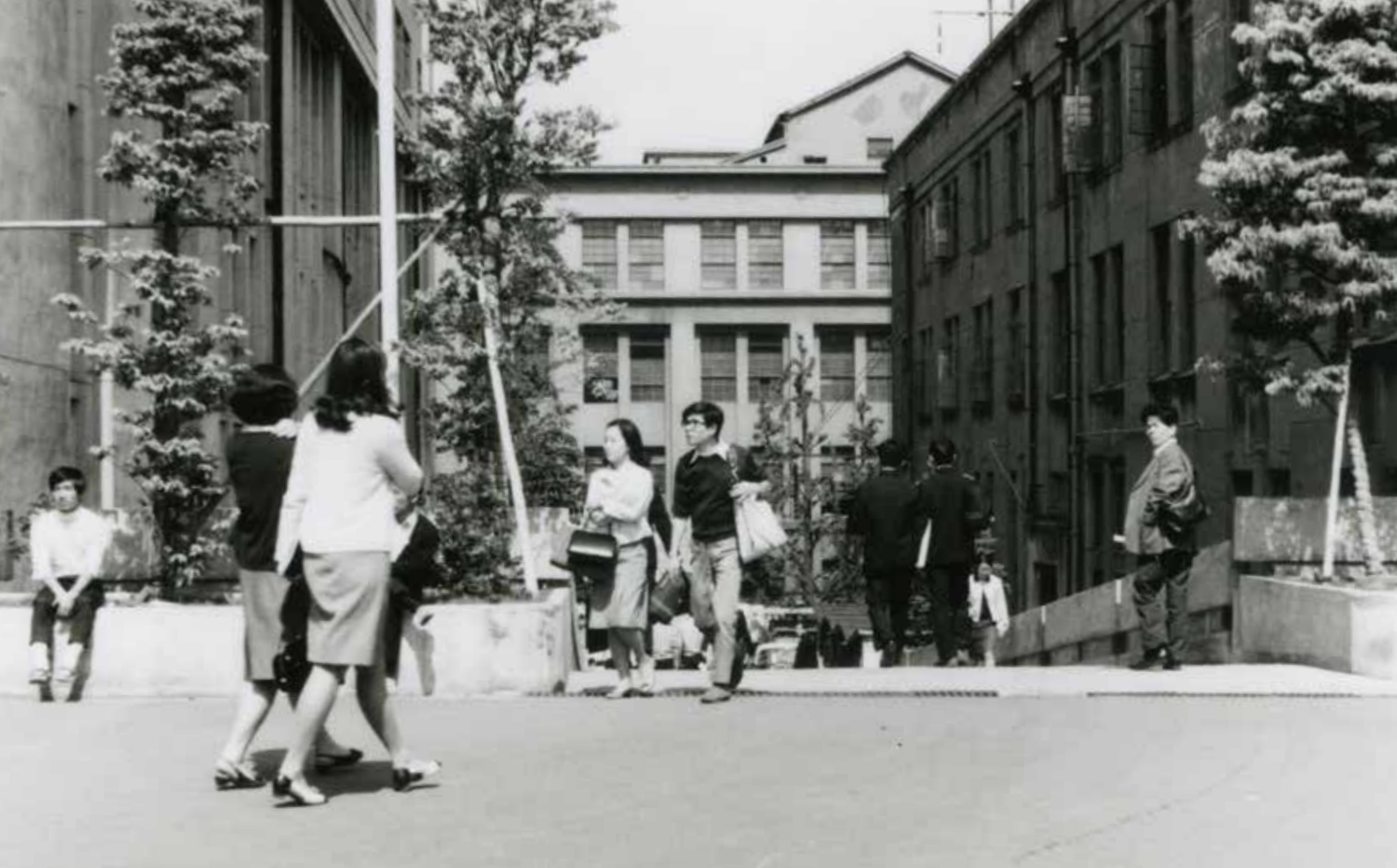
旧14号館(左側)脇スロープ。1966年(大学史資料センター蔵・2306)
